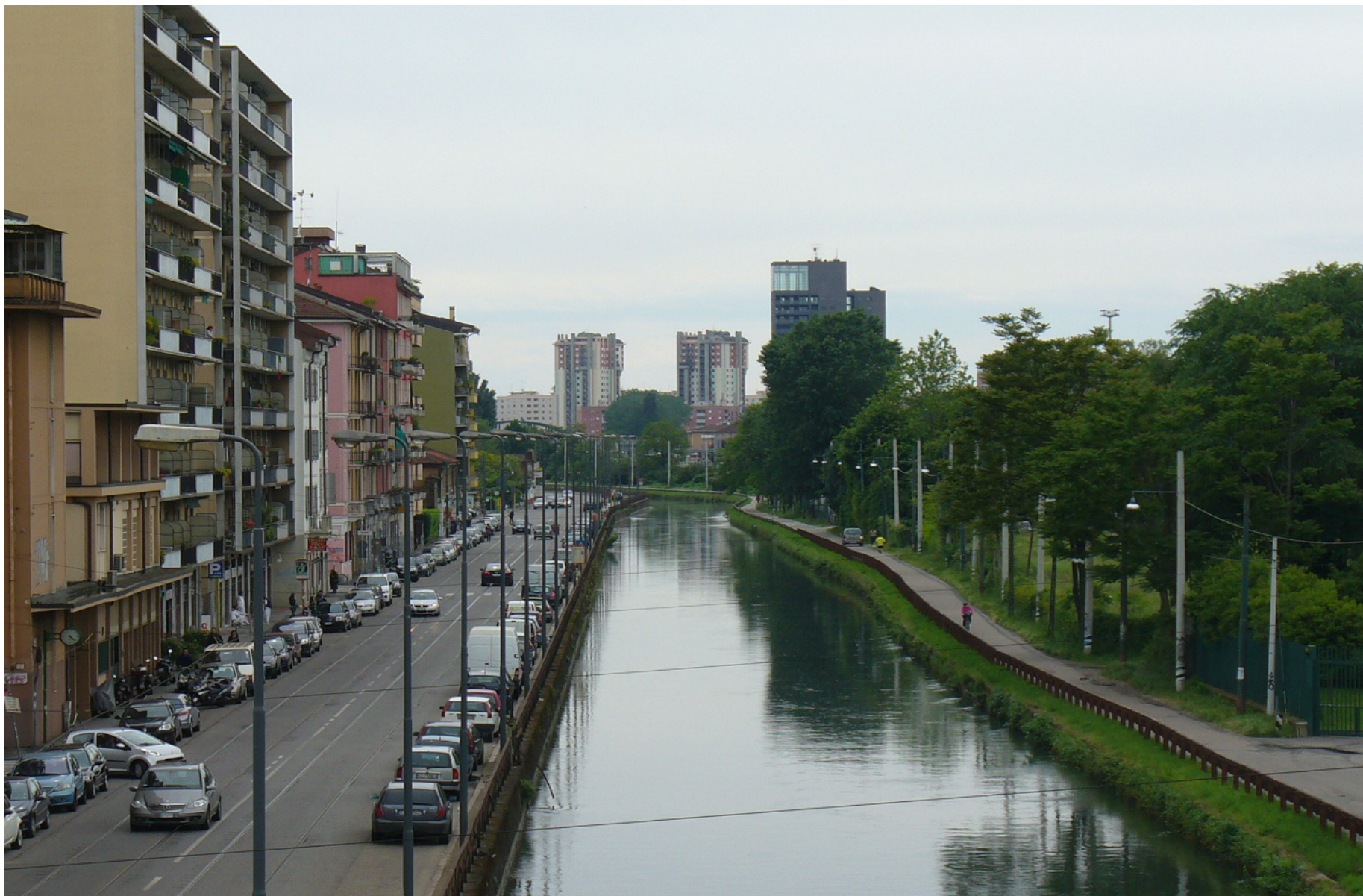
VISTA VERSO OVEST DAL CAVALCAVIA DON MILANI
