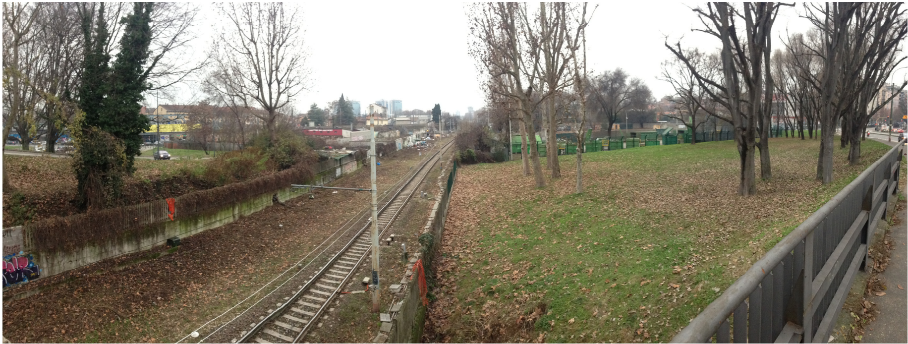
VISTA DAL CAVALCAVIA DELLE MILIZIE IN PROSSIMITA' DEL TRATTO DI FERROVIA DI PREVISTA DISMISSIONE
