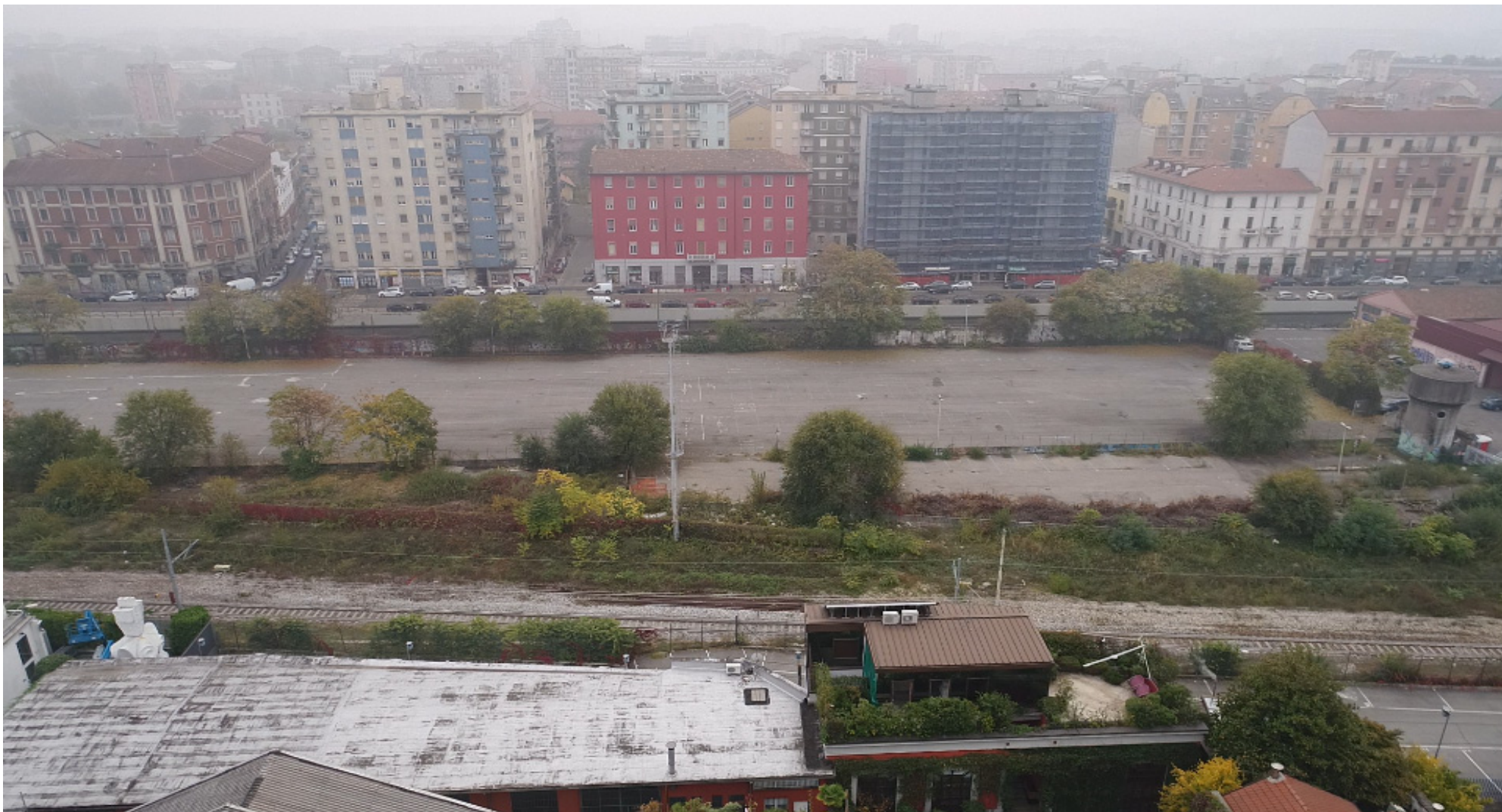
L'ULTIMO TRATTO DELLO SCALO DI PORTA GENOVA
