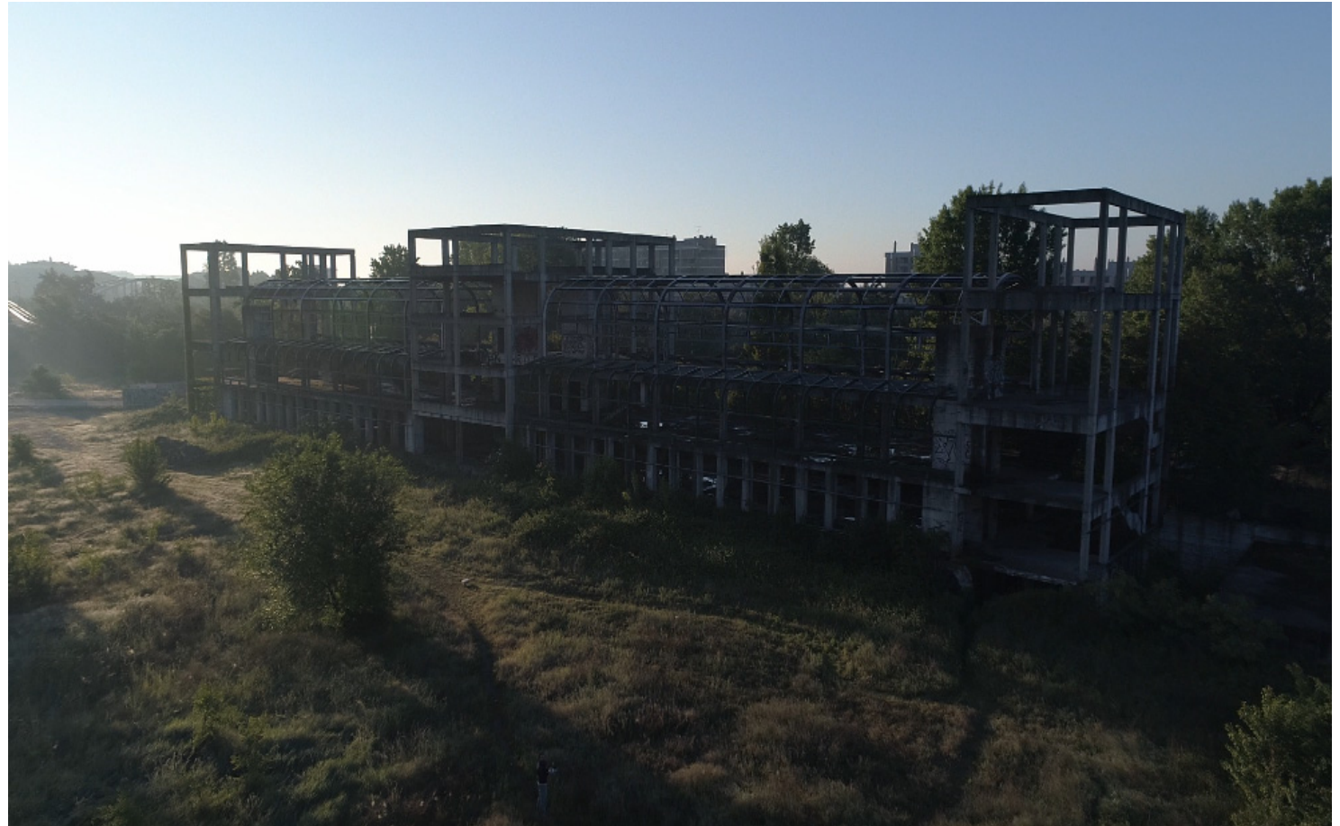
IL TERMINAL FERROVIARIO INCOMPIUTO (PROGETTO DI ALDO ROSSI)
