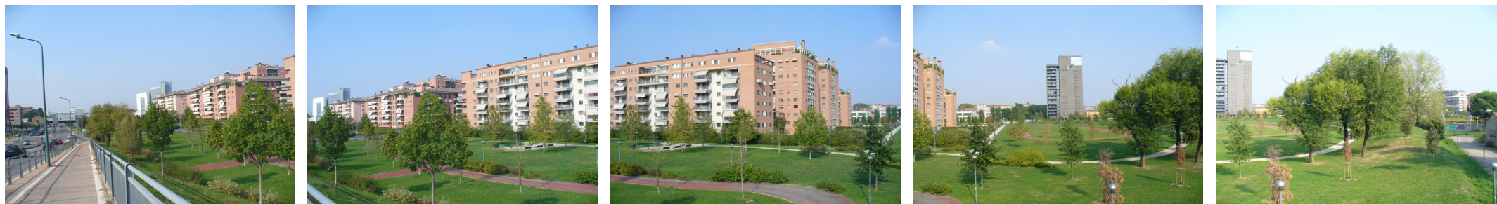
AREE PUBBLICHE A RIDOSSO DELLO SCALO FERROVIARIO DI SAN CRISTOFORO
