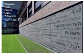
102 - Betonfassade (Sockel): Hering Bau GmbH & Co. KGFoto: BetonBild. Progetto: Bahl + Partner Architekten BDA
