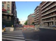
12 – Cantiere manufatto Foppa
