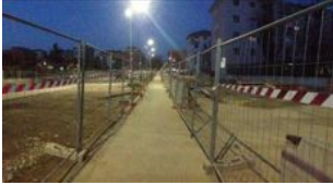
19 - Cantiere stazione Gelsomini
