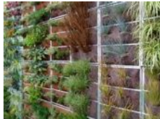
64 - Parete di verde verticale: sistema Reviwall di Reviplant
