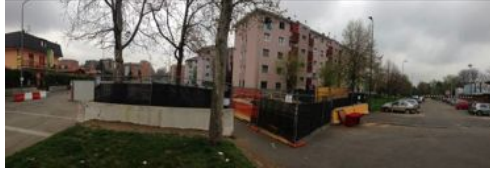
20 - Cantiere stazione Gelsomini
