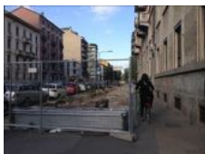
13 – Cantiere stazione Foppa
