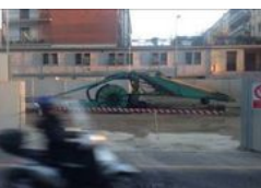
17 - Cantiere manufatto Lorenteggio civ. 124
