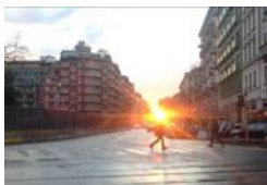
10 - Cantiere stazione Solari
