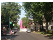
15 - Cantiere manufatto Lorenteggio civ. 25
