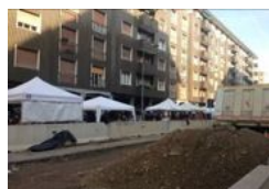
16 – Cantiere stazione Tolstoj
