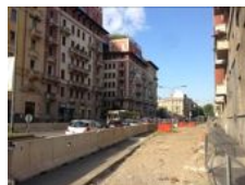
14 – Cantiere stazione Bolivar/Washington
