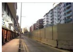
18 - Cantiere manufatto Lorenteggio civ. 124
