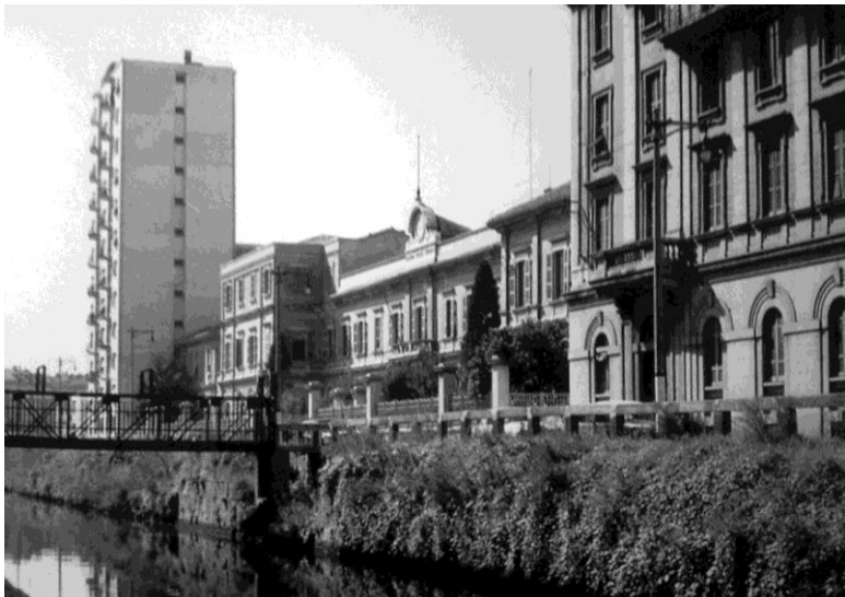
FIG. 3.2.1.19 La stazione trasformata in dogana e l'edificio residenziale e commerciale dell'arch. P. Lingeri (1955 ca)
