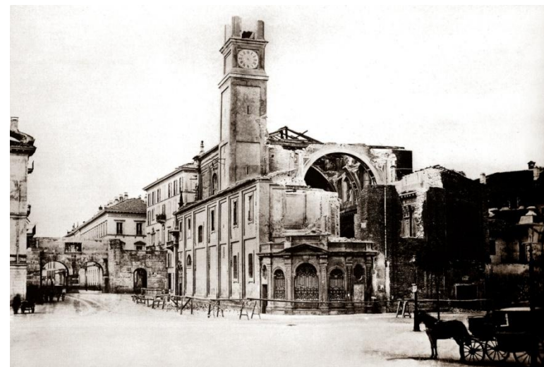
FIG. 3.2.3.1.6 Demolizione della Chiesa di San Bartolomeo (1861)
