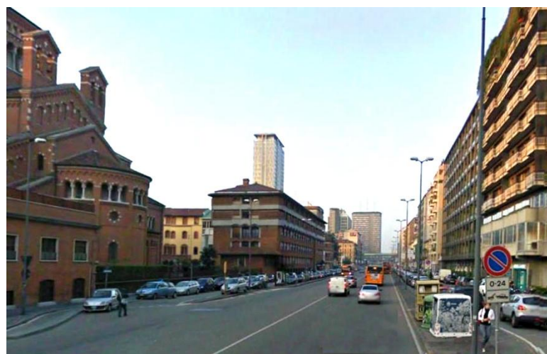
FIG. 3.2.1.47 Discontinuità dei fronti sui due lati di via Melchiorre Gioia tra via Viale Sondrio-Tonale e via Galvani
