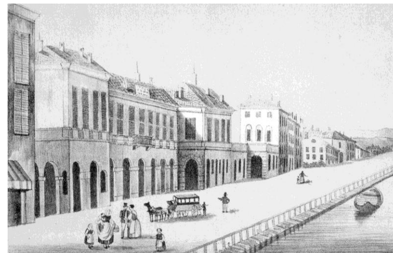
FIG. 3.2.1.16 La stazione della strada Ferrata Milano-Como (1847-50)
