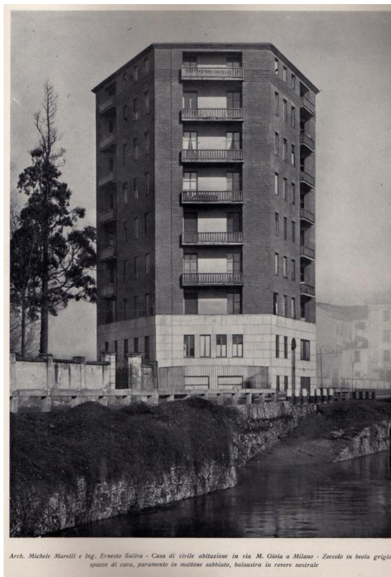
FIG. 3.2.1.39 Edificio di civile abitazione all'angolo via M. Gioia –via Algarotti (1936) – archh. M. Marelli, E. Saliva
