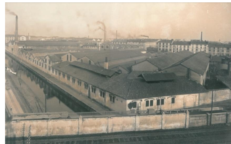
FIG. 3.2.1.36 Lo stabilimento meccanico Breda (1900 ca)
