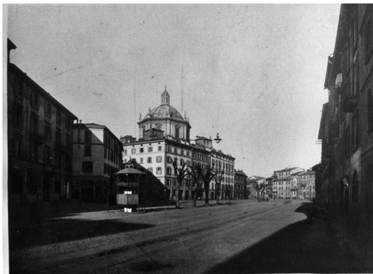
Tratto meridionale di Piazza Vetra (verso via delle Pioppette)
