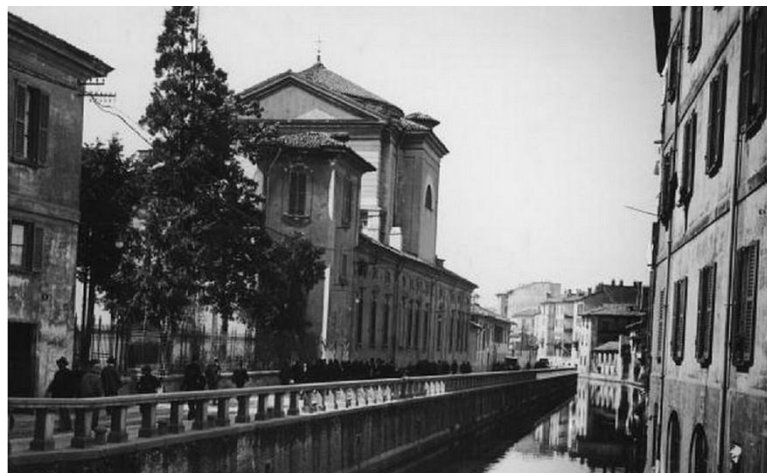
FIG. 3.2.3.2.52 Il Naviglio in via Santa Sofia. Il tratto del canale immediatamente a valle dell'incrocio con corso di Porta Romana. La magnolia grandiflora sulla sinistra esiste ancora.
